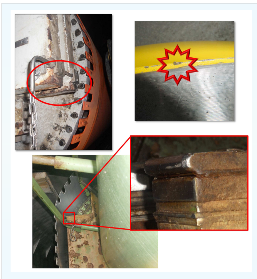
Figura 6: Exemplos de superfícies pontiagudas/cortantes expostas durante a instalação da manta.
