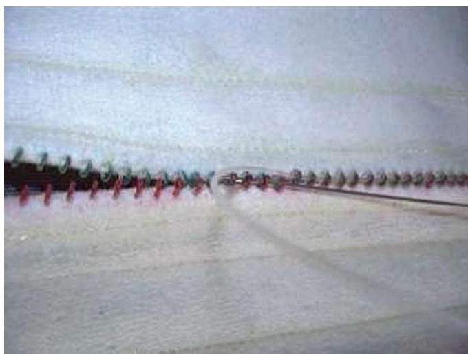
Foto 2. Instalação de tela agulhada com emenda
