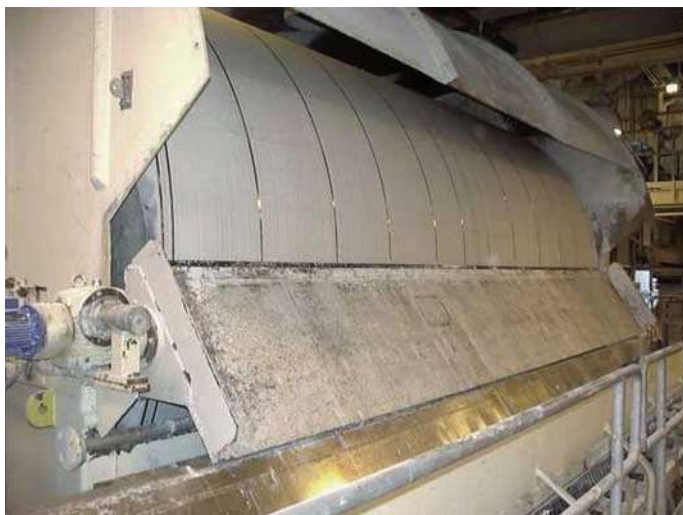
Foto 1. Vista do filtro de lama de cal
