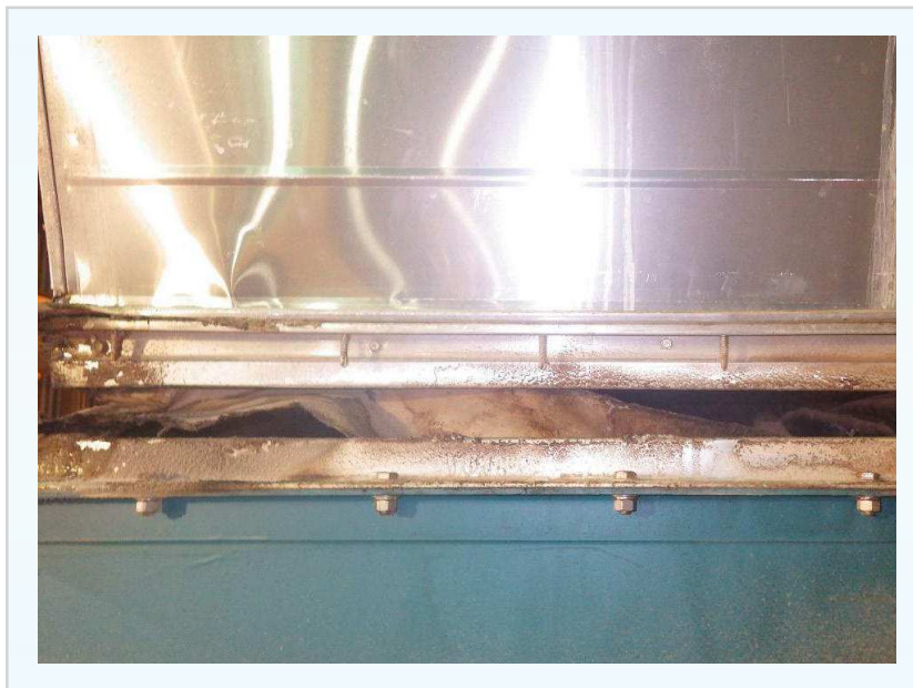
Figura 14: Anel de vedação antes do ventilador de exaustão.
