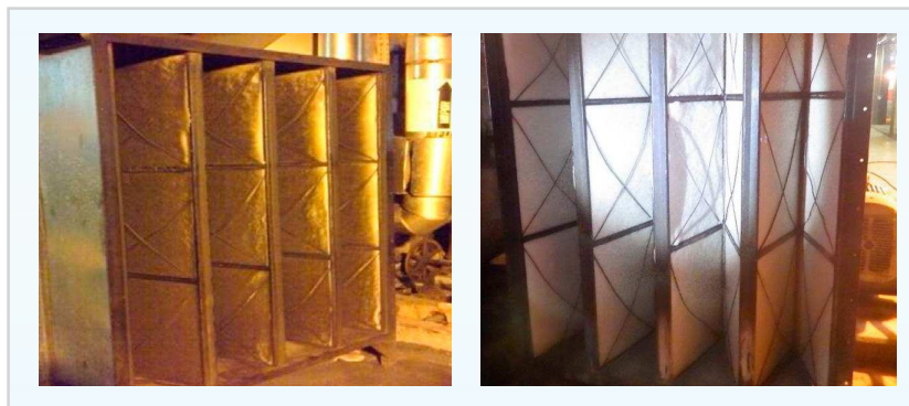
Figura 9: Fotos do sistema de captação de ar com os filtros antes e após trocas.
