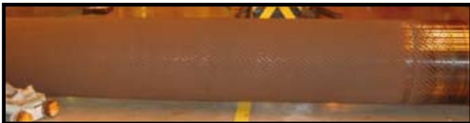
Foto 4. Corrosão de um rolo de sucção
